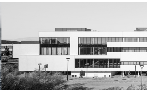
GEOLIT / 2022 Construcción e inauguración de nueva Sede Central
